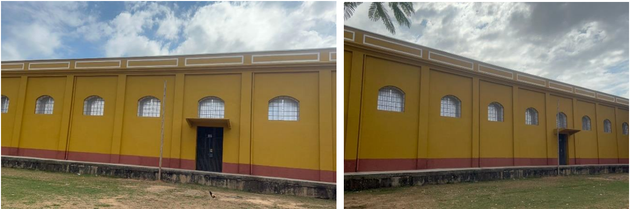
Figura 34 – Equipamentos Urbanos – Armazém Regulador do Café, hoje, sede do Instituto Tecnológico Agropecuário Nacional-ITANACIONAL. - Núcleo 01- Palma Regulariza, no Distrito de Cisneiros, no Município de Palma, Estado de Minas Gerais.
