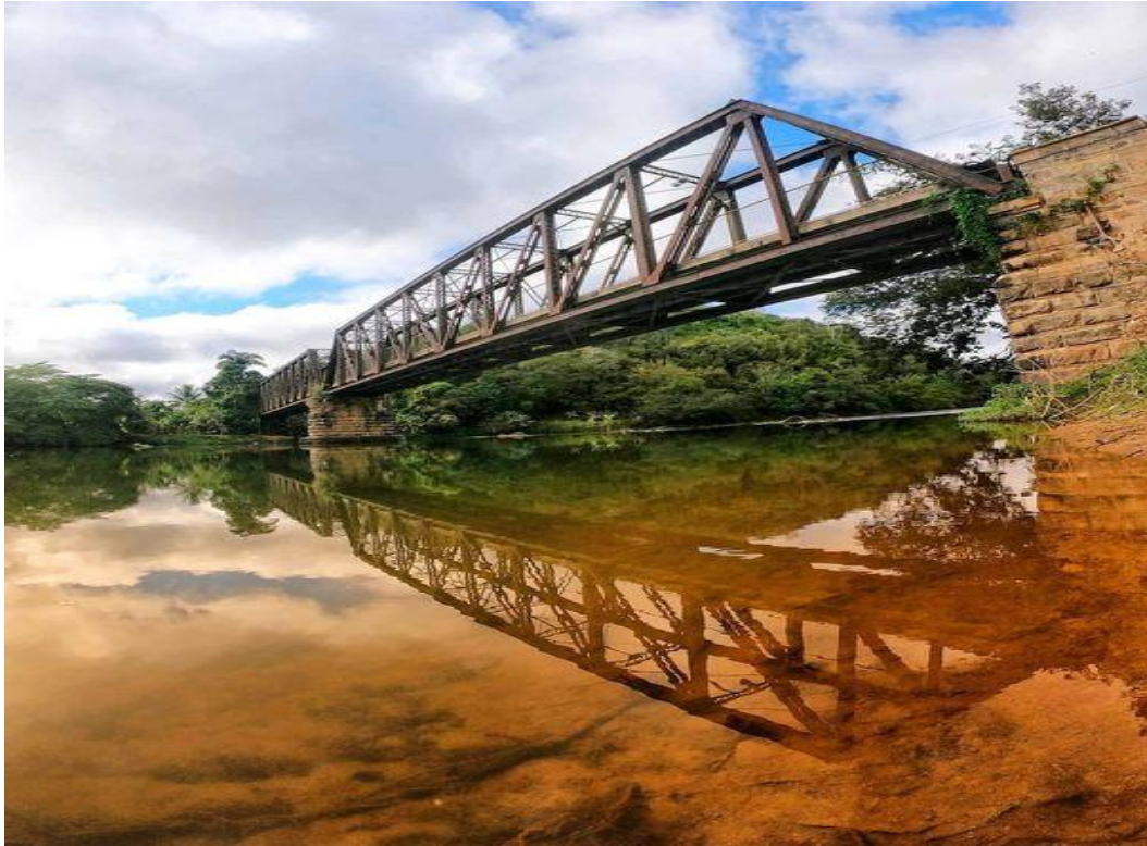
Figura 30 – Ponte Ferroviária no Distrito de Cisneiros, no Município de Palma, Estado de Minas Gerais.
