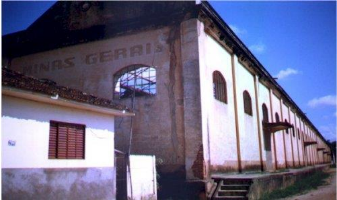
Figura 03 – Antigo Armazém Regulador localizado no Distrito de Cisneiros, no Município de Palma, Estado de Minas Gerais.
