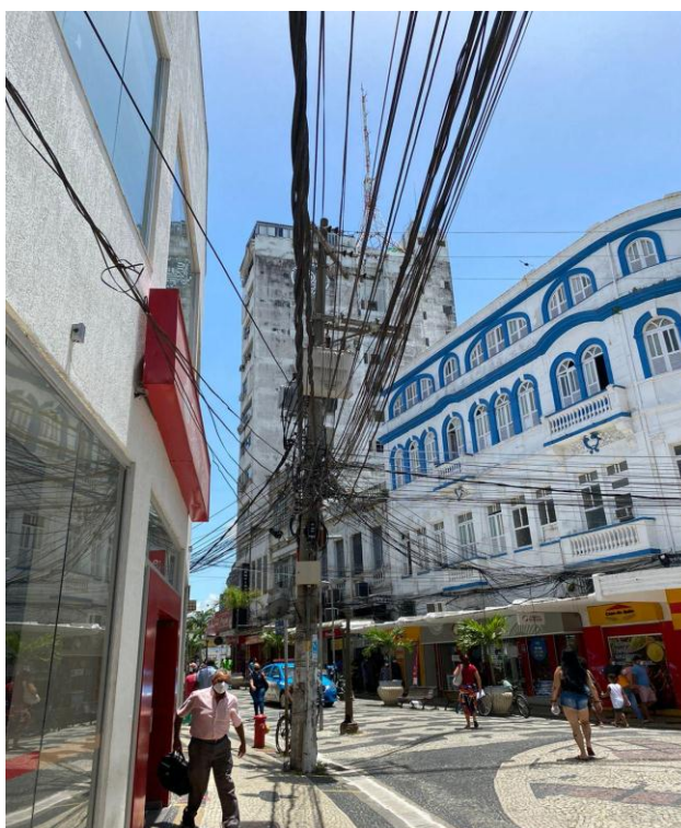
Figura 6: Cabeamento Aéreo no Boulevard Francisco de Paula Carneiro
