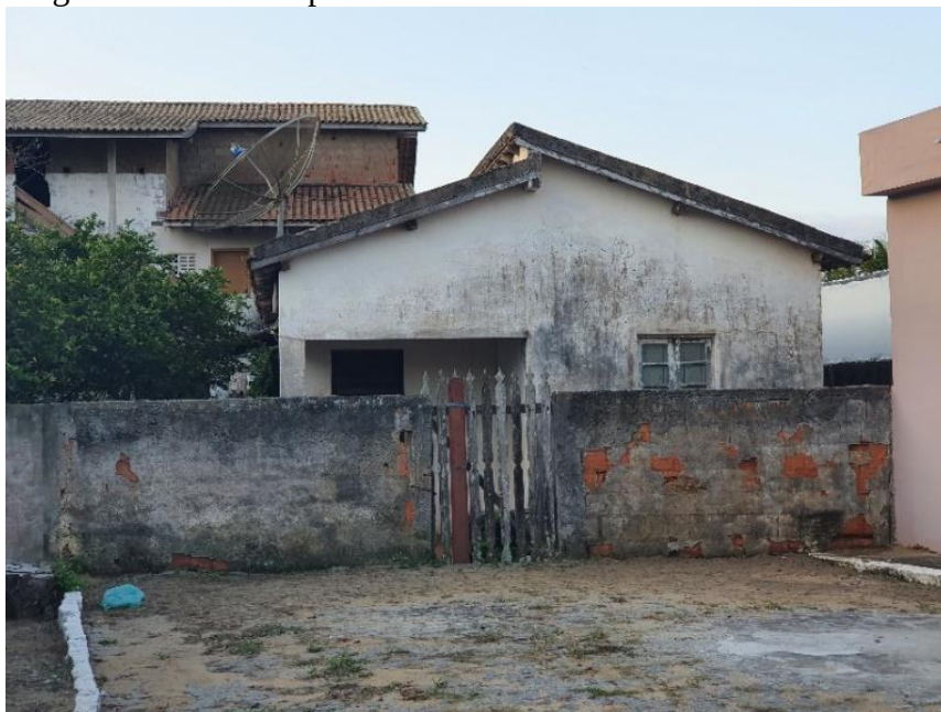
Figura 13 - Casa de pescador no V Distrito de São João da Barra
