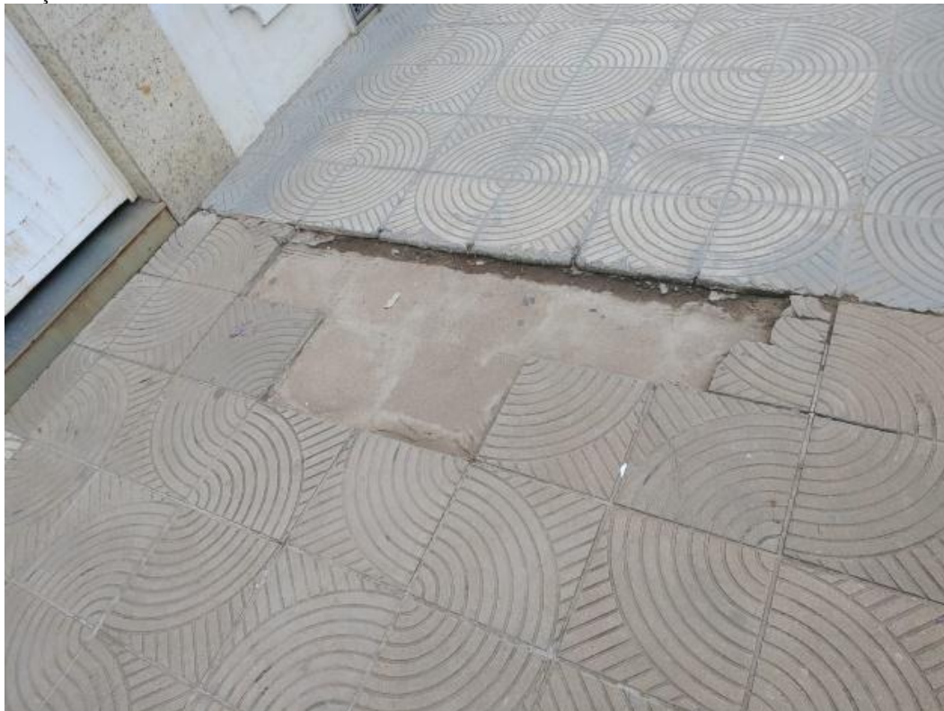
Calçada em um dos trechos da avenida da avenida Cardoso Moreira
