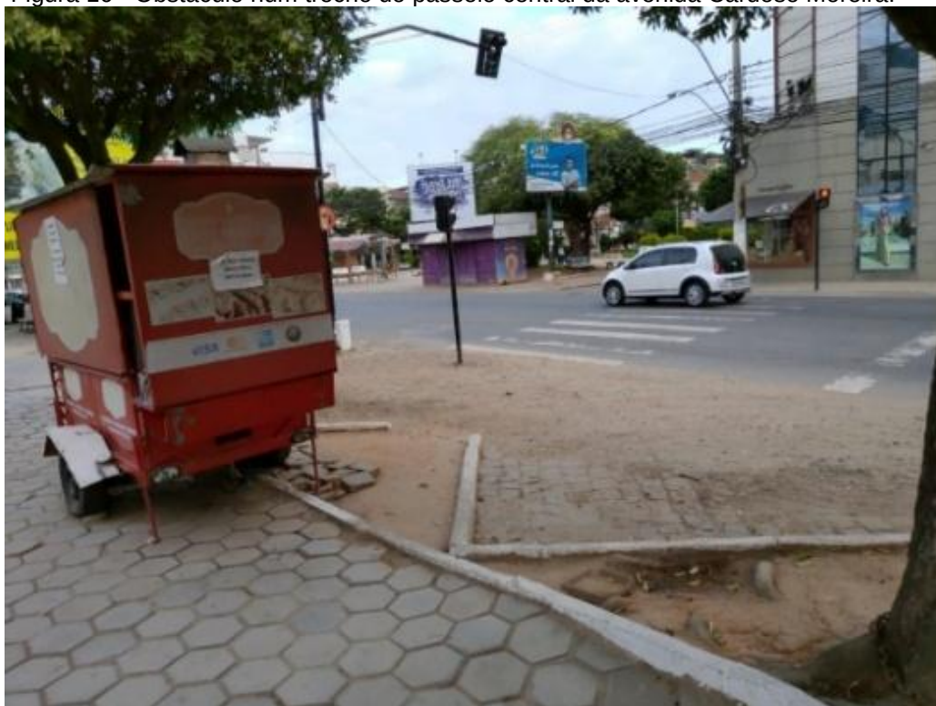
Figura 16 - Obstáculo num trecho do passeio central da avenida Cardoso Moreira.
