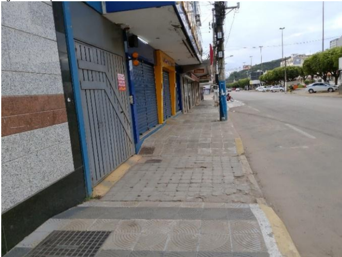
Figura 9 - Calçada em um dos trechos da avenida da avenida Cardoso Moreira.
