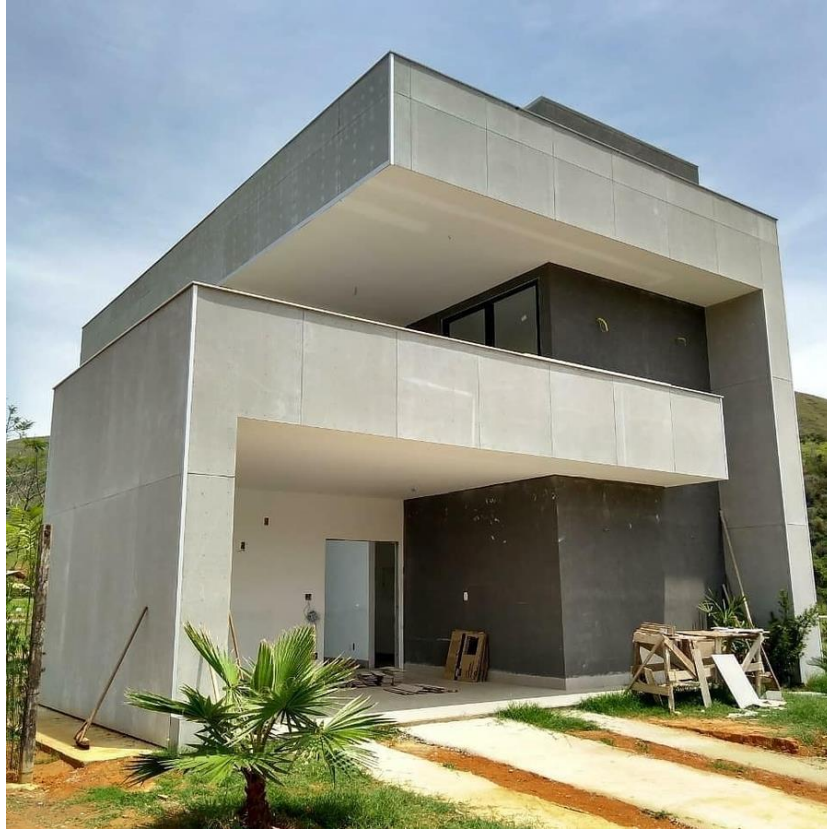
Figura 23 - Casa em construção no Green Village. Fonte: Página da facebook da Otimix.
