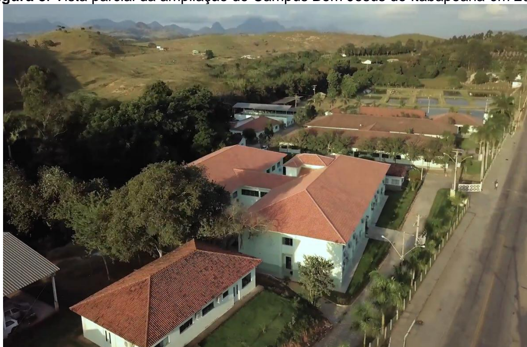
Figura 8: Vista parcial da ampliação do Campus Bom Jesus do Itabapoana em 2018
