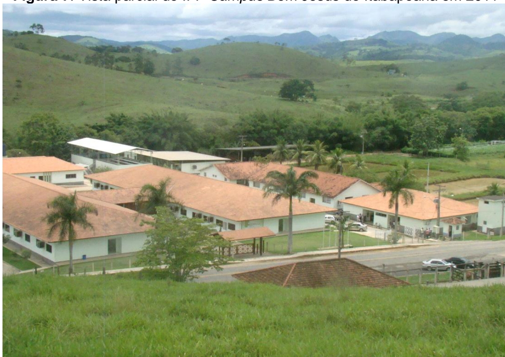
Figura 7: Vista parcial do IFF Campus Bom Jesus do Itabapoana em 2011
