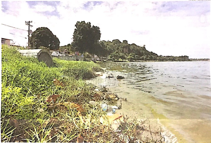
Maricá. A localidade de Jacaré, que abriga uma das lagoas da cidade, sofre com despejo do esgoto e sujeira. Moradores aguardam as melhorias prometidas pela prefeitura
