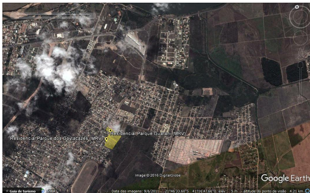
Figura 41 - Novas incorporadoras chegam à Campos. Início das obras dos condomínios da MRV.
