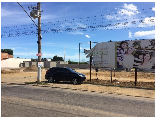
Figura 15 - Condomínio do Bosque Residence Club, em construção. Fonte: Acervo Pessoal, 2016.
