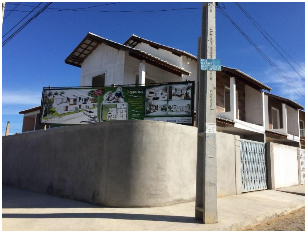
Figura 74 - Casas voltadas para rua Manoel Nascimento, próximas à Avenida Presidente Kennedy.
