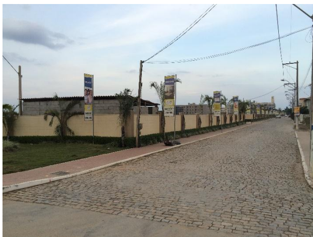
Figura 9 - Condomínio Residencial Parque Gaia, ainda em obras. Fonte: Acervo Pessoal, 2016.
