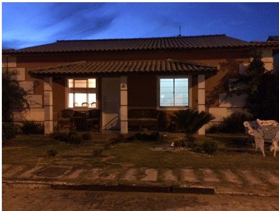
Figura 75 - Casas do Condomínio Residências Moradas do Sol, localizado na Rua Rosa Montesano.
