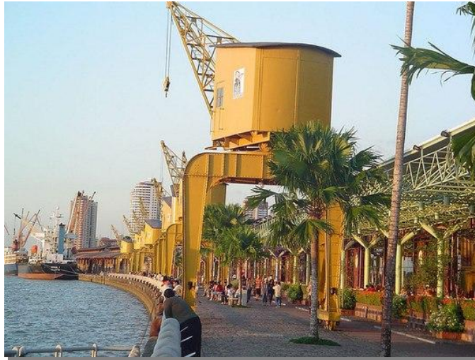
Figura 20: Estação das Docas, com os guindastes do antigo porto Fonte: Getty Images (2015).
