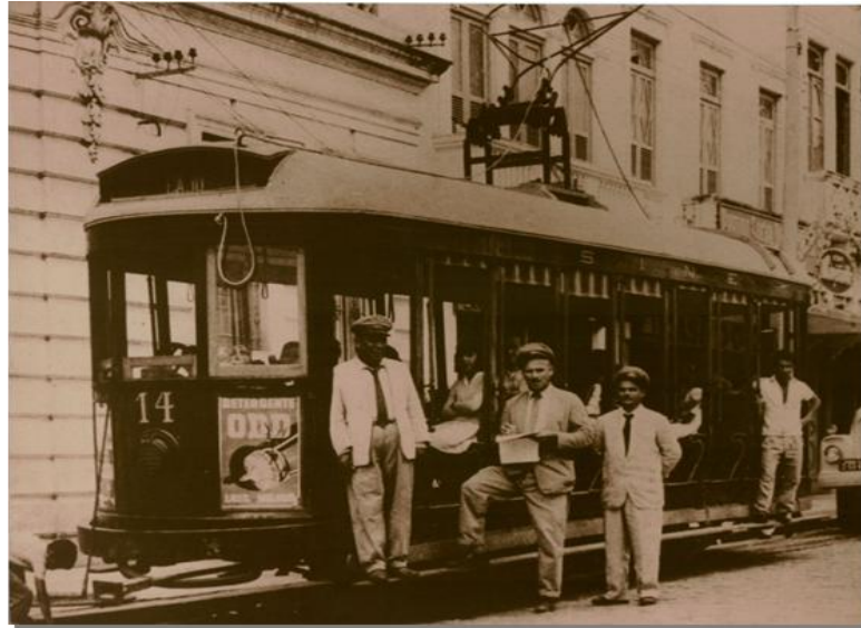
Figura 37: Bonde elétrico no Centro de Campos dos Goytacazes Fonte: Arquivo Público Municipal de Campos dos Goytacazes (2015).
