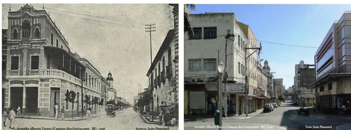
Figura 59: Esquina da Praça São Salvador: Avenida Alberto Torres (Imagens de 1901 e 2015) Fonte: Pimentel (2014)
