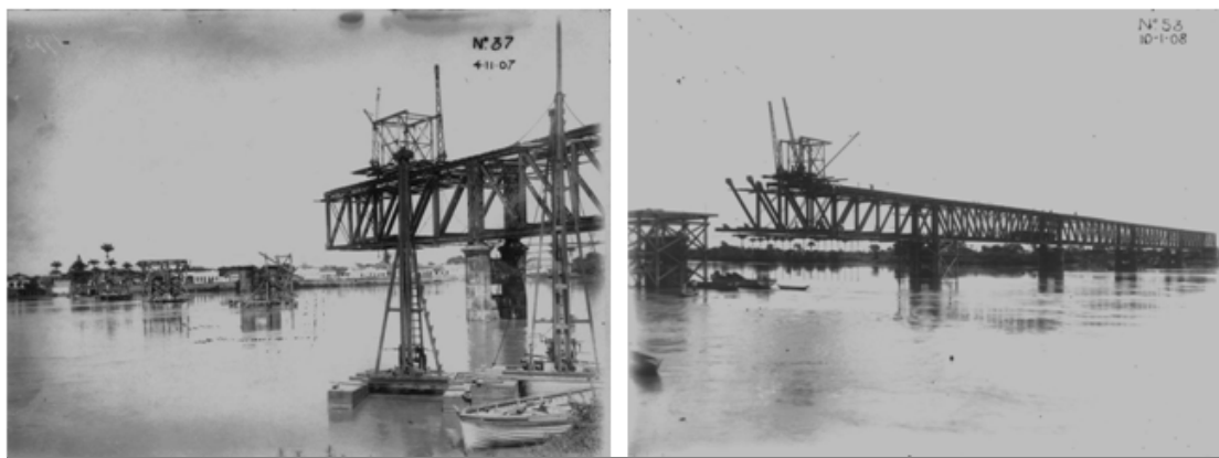
Figura 38: Construção da Ponte Ferroviária (1908). Fonte: Arquivo Público Municipal de Campos dos Goytacazes (2015).
