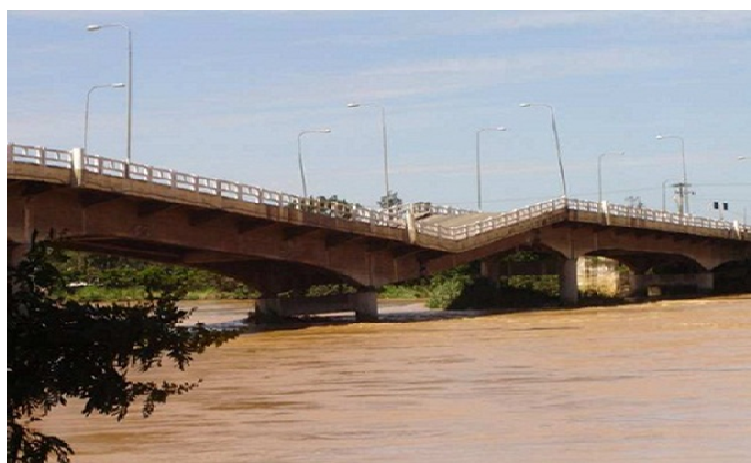
Figura 35: Queda de Ponte General Dutra, em 2007 Fonte: Urururau: Jornal online. Disponível em: < http://novosite.ururau.com.br/ >. Acesso em: 12 dez.2014
