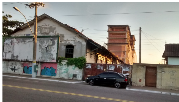
Figura 57: Prédios da Universidade Federal Fluminense (UFF) em construção, com Galpão da antiga Estação à frente Fonte: Elaborado pelo Autor (2015).
