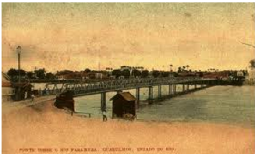
Figura 36: Ponte Municipal, atual Ponte Barcelos Martins Fonte: Arquivo Público Municipal de Campos dos Goytacazes (2015)
