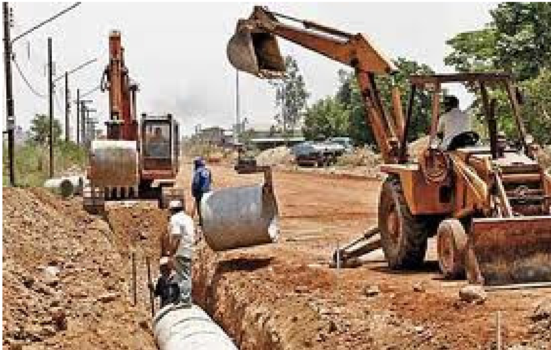
Rede de esgotamento sanitário – Macaé-RJ - 2012
