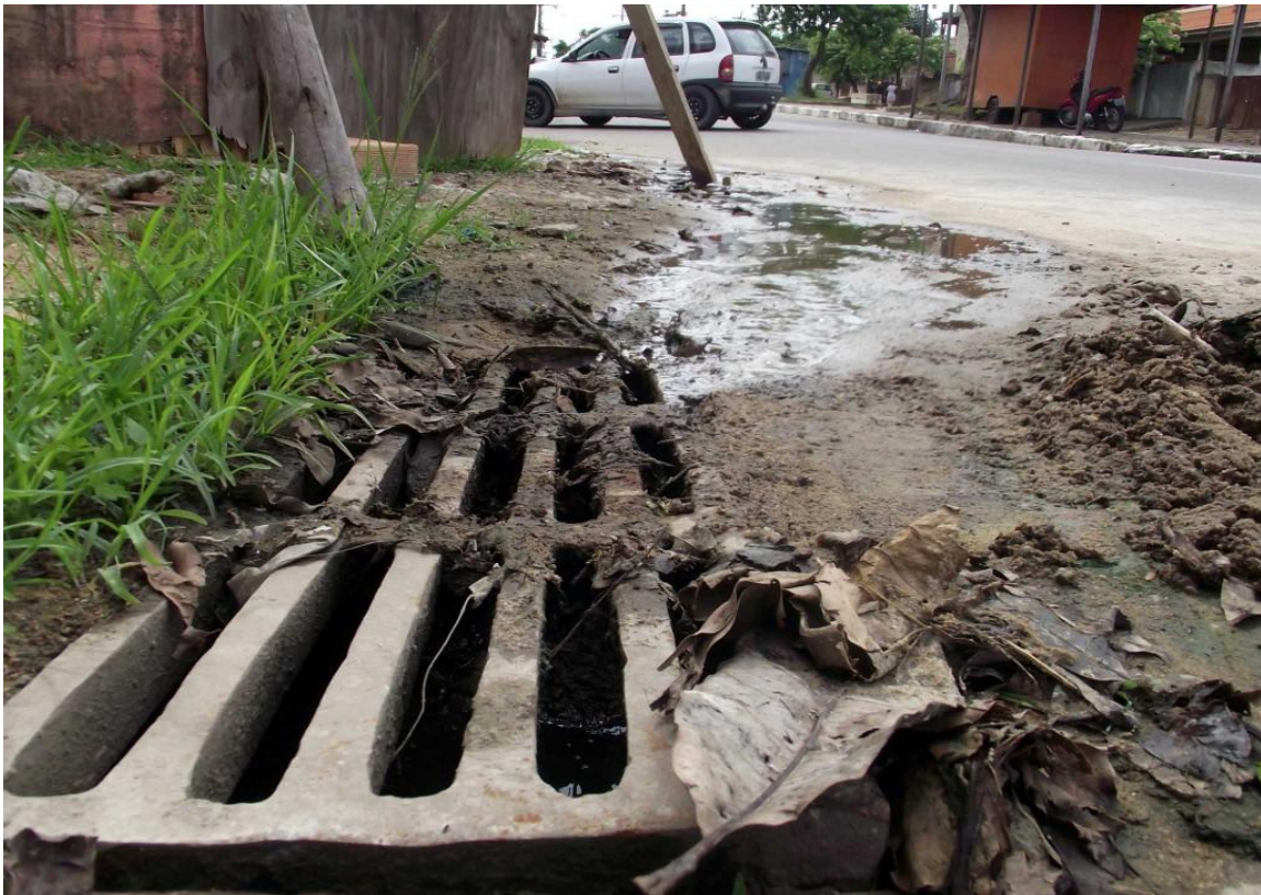
Rede de esgotamento de águas fluviais Campos dos Goytacazes-RJ - 2012
