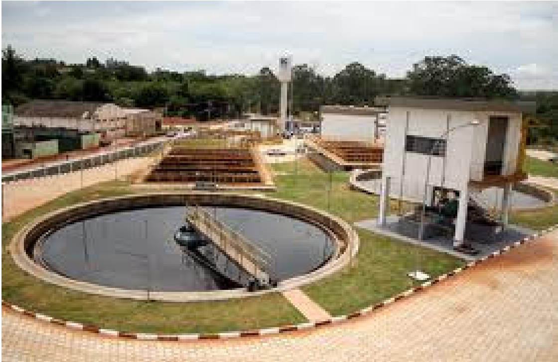
Estação de tratamento sanitário – Campos dos Goytacazes-RJ - 2012
