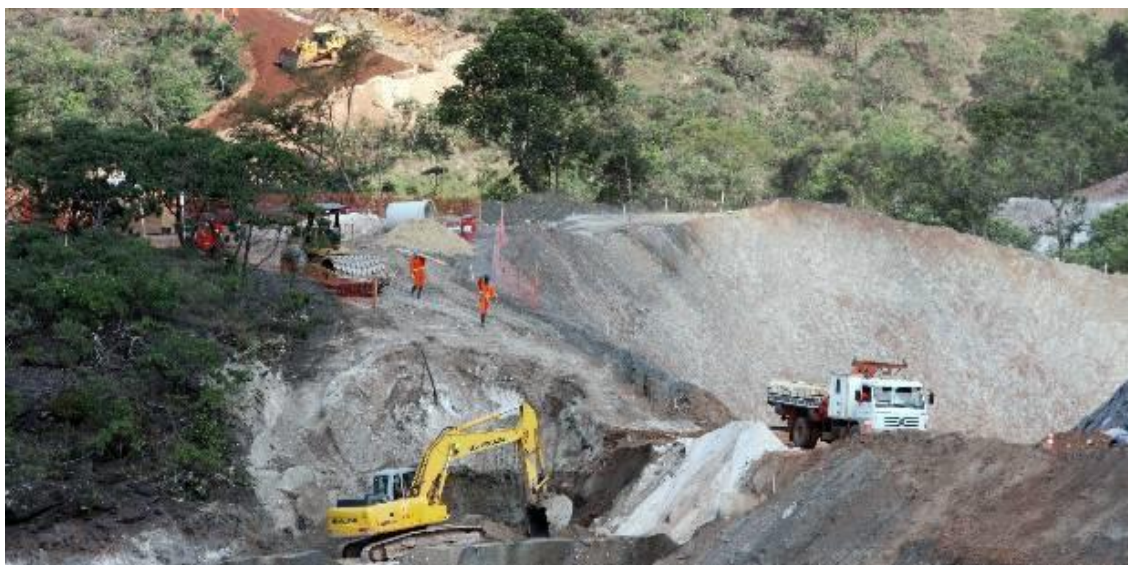
Figura 8: Serra da Ferrugem- MG (2011). Exploração de minério de ferro
