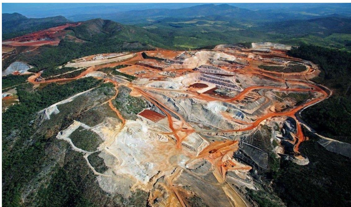
Figura 9: Conceição do Mato Dentro (MG): serra da Ferrugem Planta de Beneficiamento
