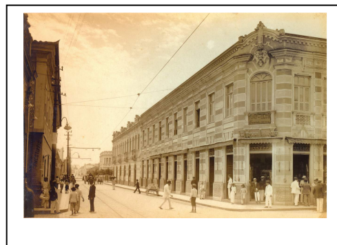
[FOTOS 5 e 6; 7 e 8 – Ao Livro Novo – antes e depois das reformas Rua sete de setembro estreita e alargada] e
