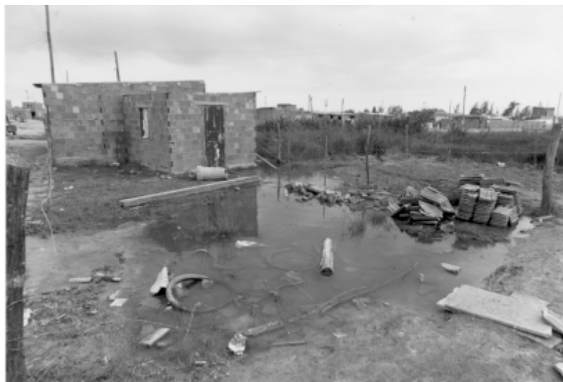
Situação da drenagem na Malvinas em 1989
