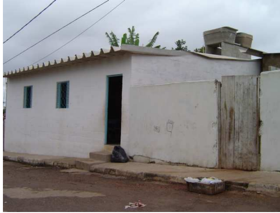
Galpão construído pela empresa Queirós Galvão (Arquivo pessoal. setembro. 2003)
