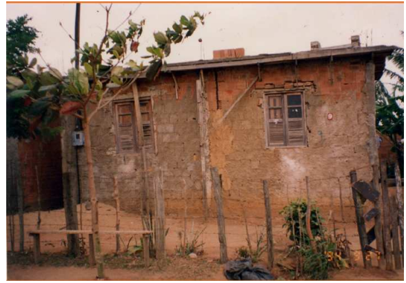
Casa de alvenaria com relógios de luz (Arquivo do projeto João de Barro. Setembro. 1994)
