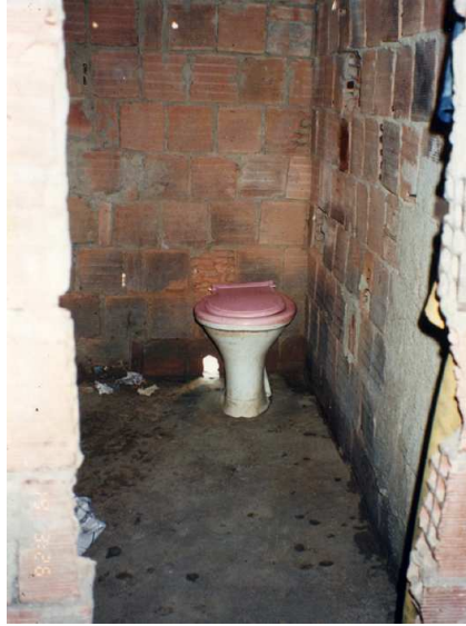
Banheiro de casa da Terra Prometida – vaso sanitário sem ligação com a rede de esgotos (Arquivo do projeto João de Barro. Setembro. 1994)
