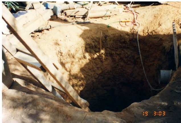
Fossa em terreno da Terra Prometida (Arquivo do projeto João de Barro. Setembro. 1994)
