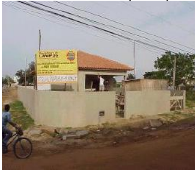
Foto 16: Posto de saúde em Construção – Avenida São João da Barra
