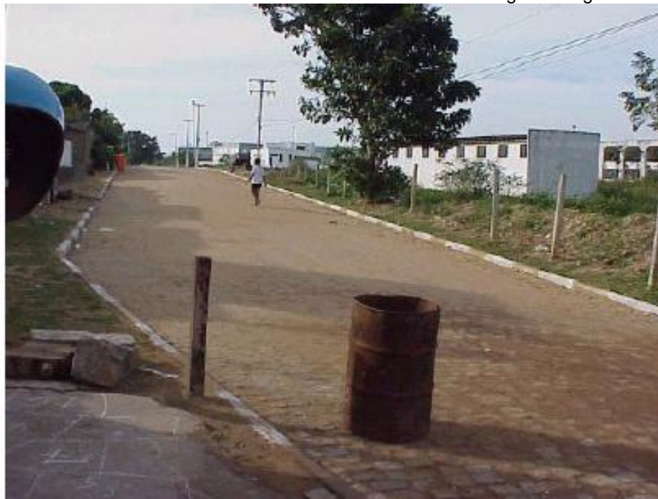
Foto 21: Pavimentação da Avenida São João da Barra atrás da UENF
