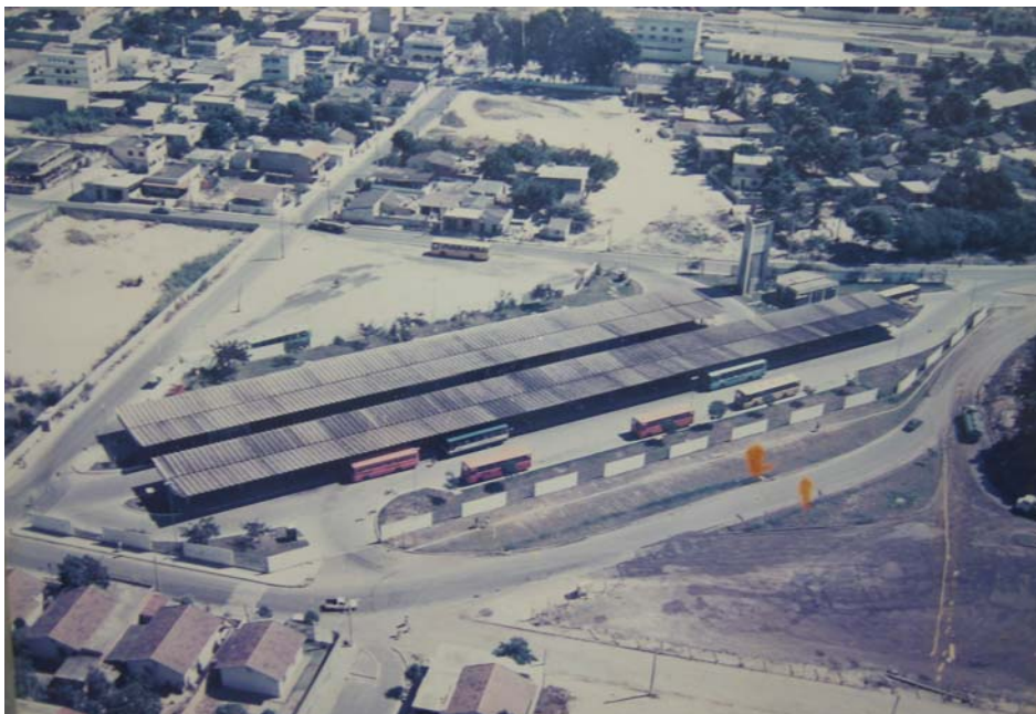
Figura 20. Terminal de Carapina (situação anterior à ampliação) – 1989, a partir de CETURB, 1988
