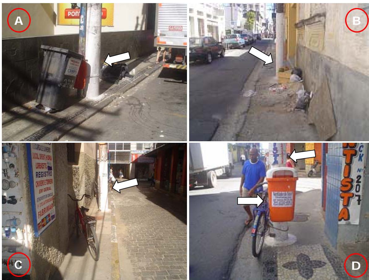
Figura 12 – Seqüência de postes instalados no meio das calçadas no centro da cidade. Foto “A”: rua 21 de abril, foto “B”: rua Carlos de Lacerda, foto “C”: travessa Carlos Gomes e foto “D”: rua Santos Dumont.
