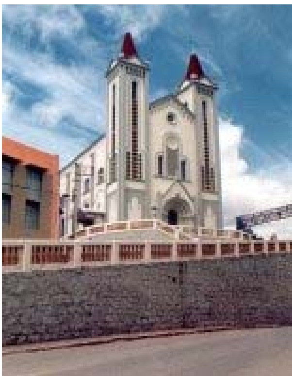
Figura 6. Igreja Matriz, no município de Alegre. A capela Mor de Alegre começou a ser construída em barro e madeira no ano de 1851, por iniciativa dos primeiros exploradores da região. Oficialmente, as terras do patrimônio de Alegre ficaram sobre responsabilidade da igreja com a condição de que esta doaria as terras à Nossa Senhora da Penha. Em 1868 o corpo da igreja foi edificado e a Capela Mor reparada. Novas ampliações foram realizadas entre 1914 e 1916 e também entre 1953 e 1968. Todas essas reformas resultaram num estilo barroco-gótico. A igreja de Nossa Senhora da Penha possui ainda magníficos vitrais retratando a vida de Cristo e pinturas do Indiano Diwali. Fonte: Canal do Turismo (2007).
