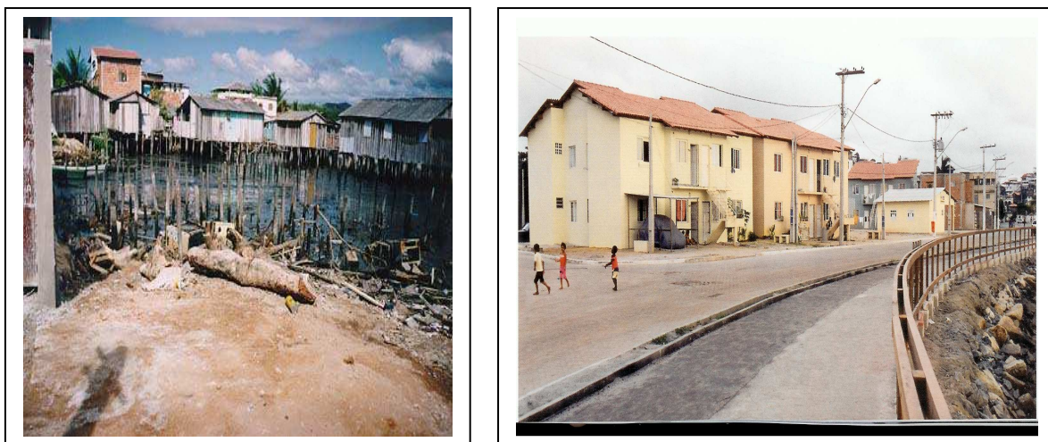
Figura 14: Intervenções – Unidades habitacionais do Projeto Terra (Poligonal 8) – Bairro Santo Antônio.
