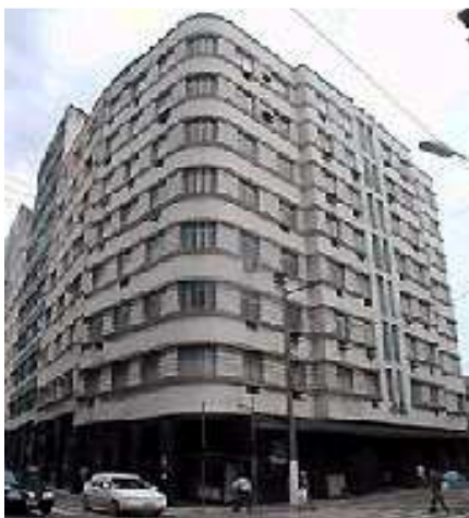
Figura 17 – Edifício do INSS Fonte: PMV/SEHAB (2005)
