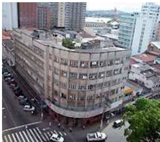
Figura 18 – Edifício Santa Cecília Fonte: PMV/SEHAB (2005)
