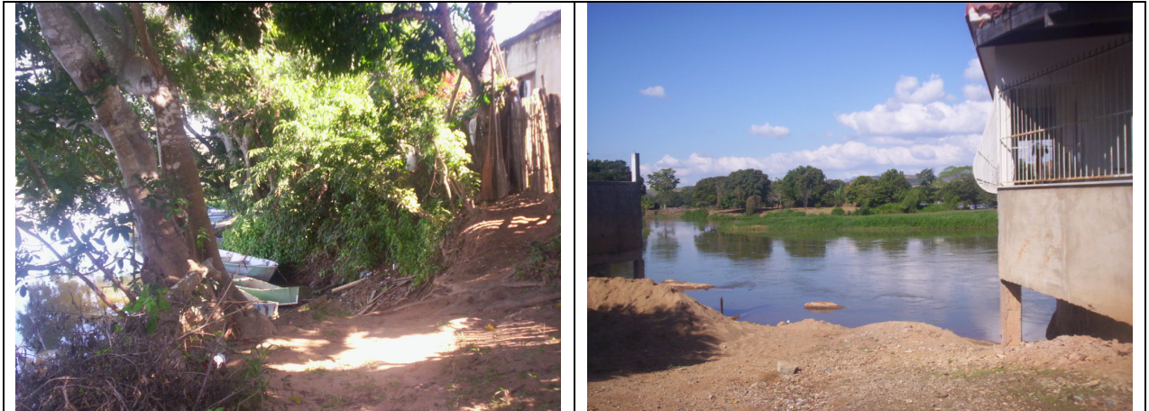
FIGURA 12: FUNDOS DE RESIDÊNCIAS DA RUA BEIRA RIO QUE MARGEIAM O RIO PARAÍBA DO SUL FONTE: FOTOGRAFIA RETIRADA PELO AUTOR DURANTE A APLICAÇÃO DO PROTOCOLO
