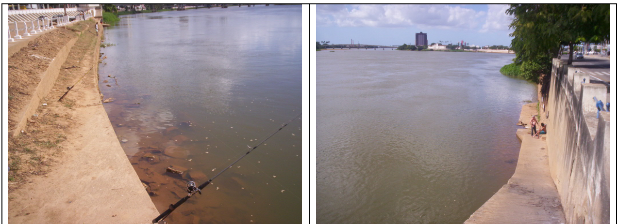
FIGURA 20: VISTA DO DIQUE DO RIO PARAÍBA DO SUL NO PERÍMETRO URBANO DE CAMPOS DOS GOYTACAZES
